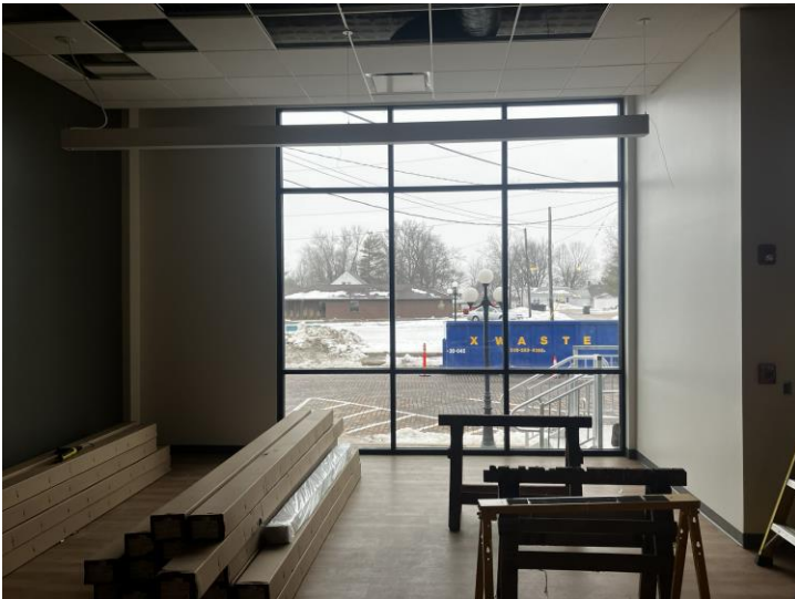
5. AV 104, Looking North
