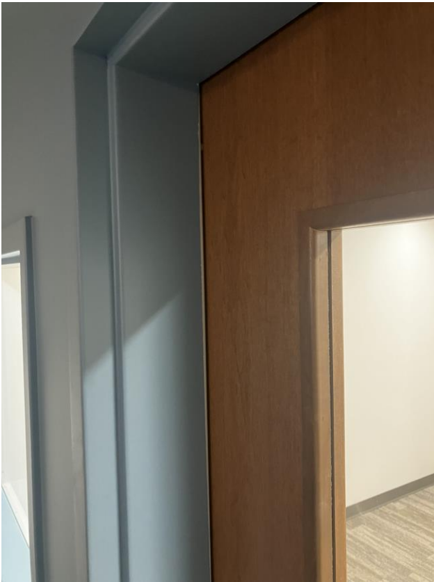
14. Door Frame at Door 110A
